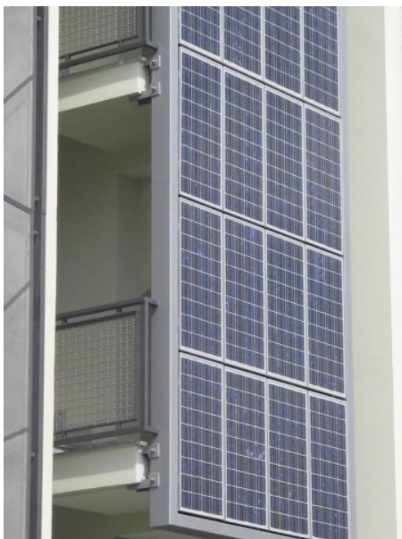
(esempio di parete verticale con pannelli solari)
